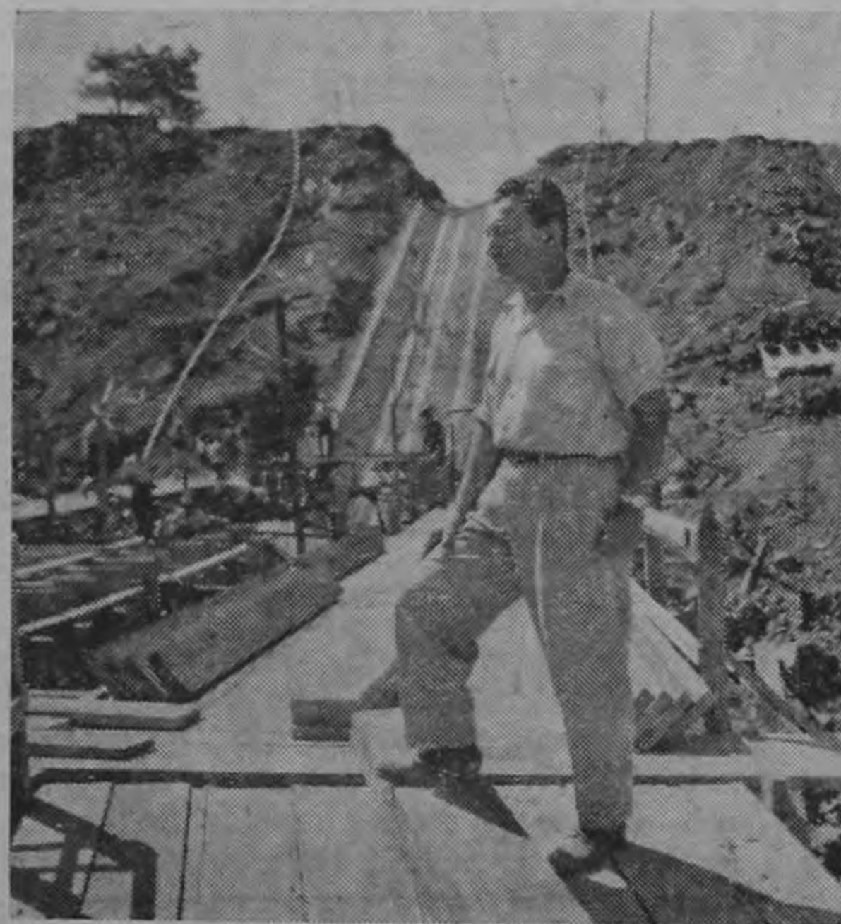
Ingeniero Cipriano C. Caves Núñez, encargado de la construcción del sifón.
